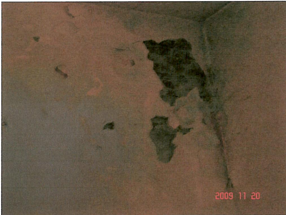
Fot nr 1. Zawilgocenie i zagrzybienie ścian
