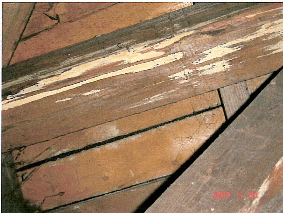
Fot nr 4. Ślady grzyba domowego białego
