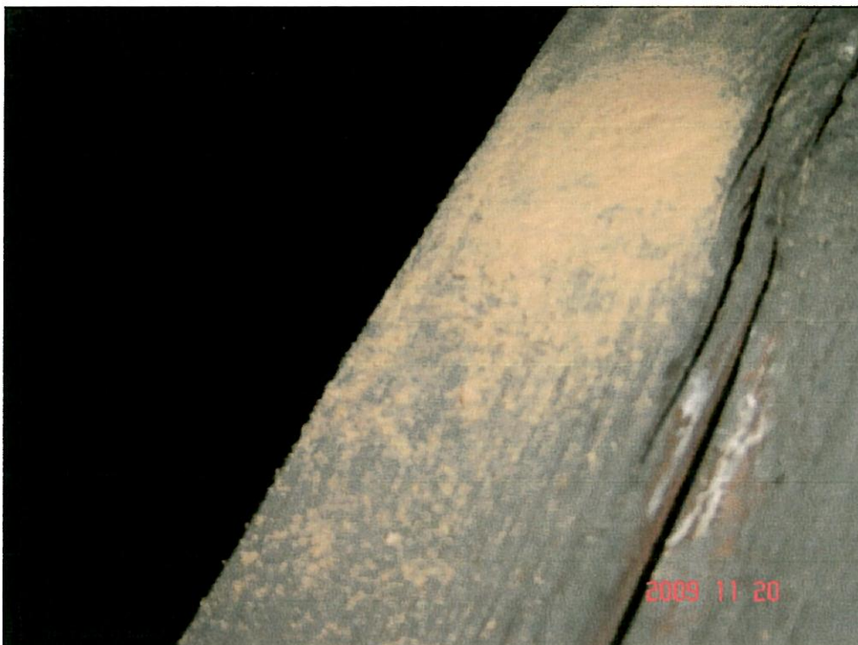
Fot nr 6. Maczka drzewna wysypująca się z porażonej krokwi
