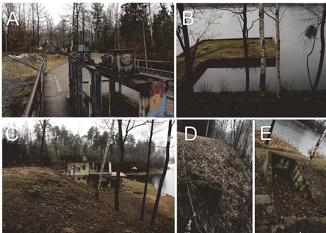
Fot. 6. Infrastruktura budowlana wokół zbiornika Rogoźnik I: A – Zastawki Jaz 2 (zasuwy płaskie podnoszone mechanizmami palczatkowymi); B – stara przystań na wschodnim brzegu zbiornika; C – ruiny starej kawiarni; D – studzienka instalacji odwodnienia nieistniejącej infrastruktury, E – fundamenty nieistniejącej infrastruktury
