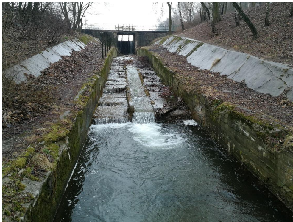
Fot. 2. Ilość wody dostarczanej ze zbiornika Rogoźnik II do zbiornika Rogoźnik I może być regulowana za pomocą jazu (29.03.2018, fot. Damian Absalon)
